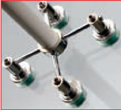
Esempio di foratura per inserimenti in vetrata strutturale. Example of drilling for metal insertion in structural glass.
